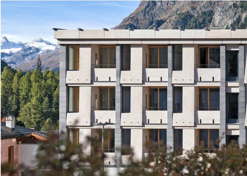
Hotel Maistra 160, Pontresina // Foto: Ralph Feiner, Malans
